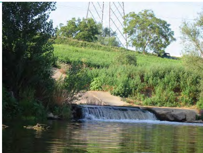
Arno - Scarico del Depuratore di San Colombano
