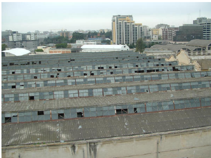
Figura 6 - La Fibronit di Bari prima degli interventi
